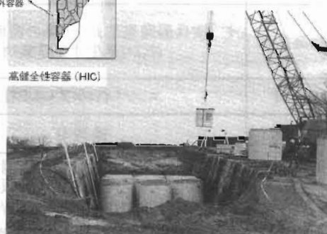
高健全性容器廃棄体の処分状況 (クラスB廃棄物)
