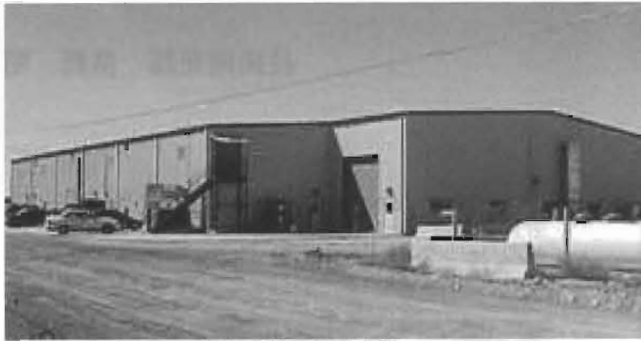
混合廃棄物処理施設
